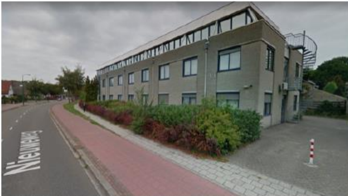
Nieuweweg Transformeren van kantoorpand naar 19 sociale huur appartementen
