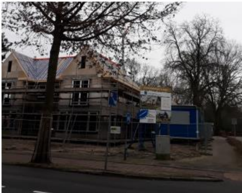
Soesterbergsestraat, nieuwbouw 2 dubbele woonhuizen
